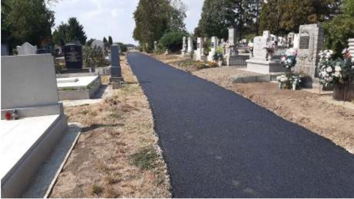
A 4. sz. belső út a 3. csatlakozása felől fotózva.
