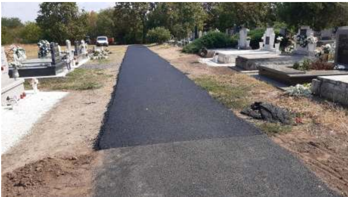
A 3. sz. belső út a 2. út csatlakozása felől.
