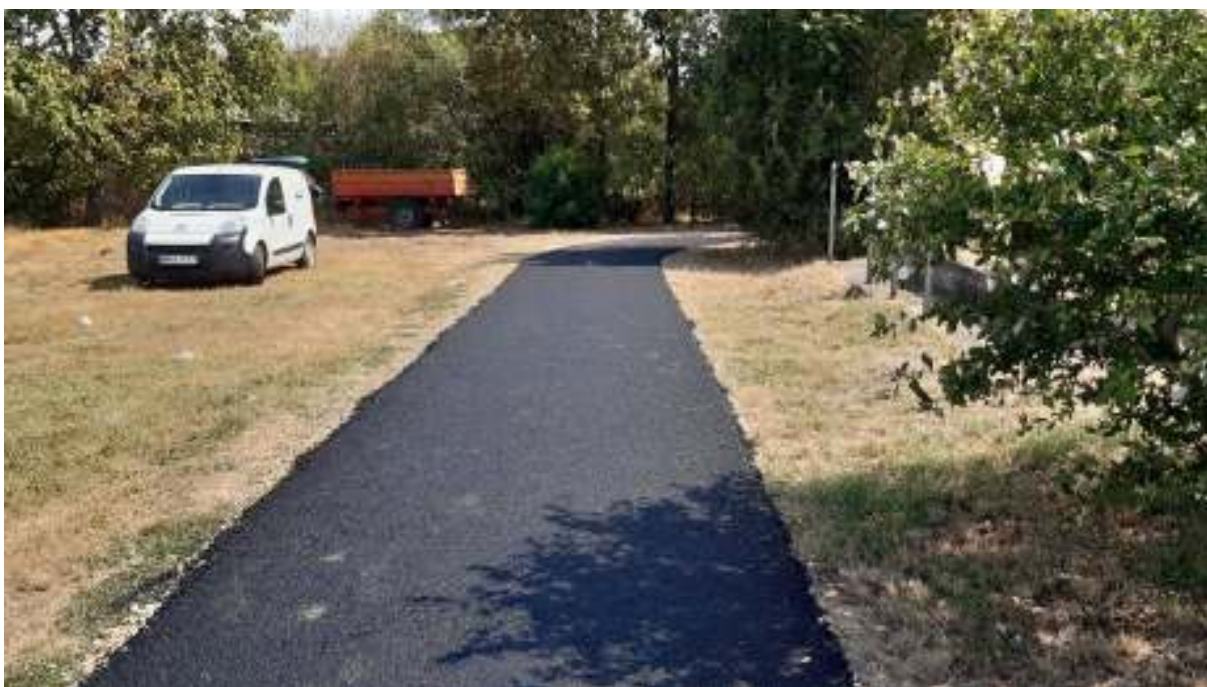
A 3. sz. belső út a 2. sz. csatlakozás felől II.
