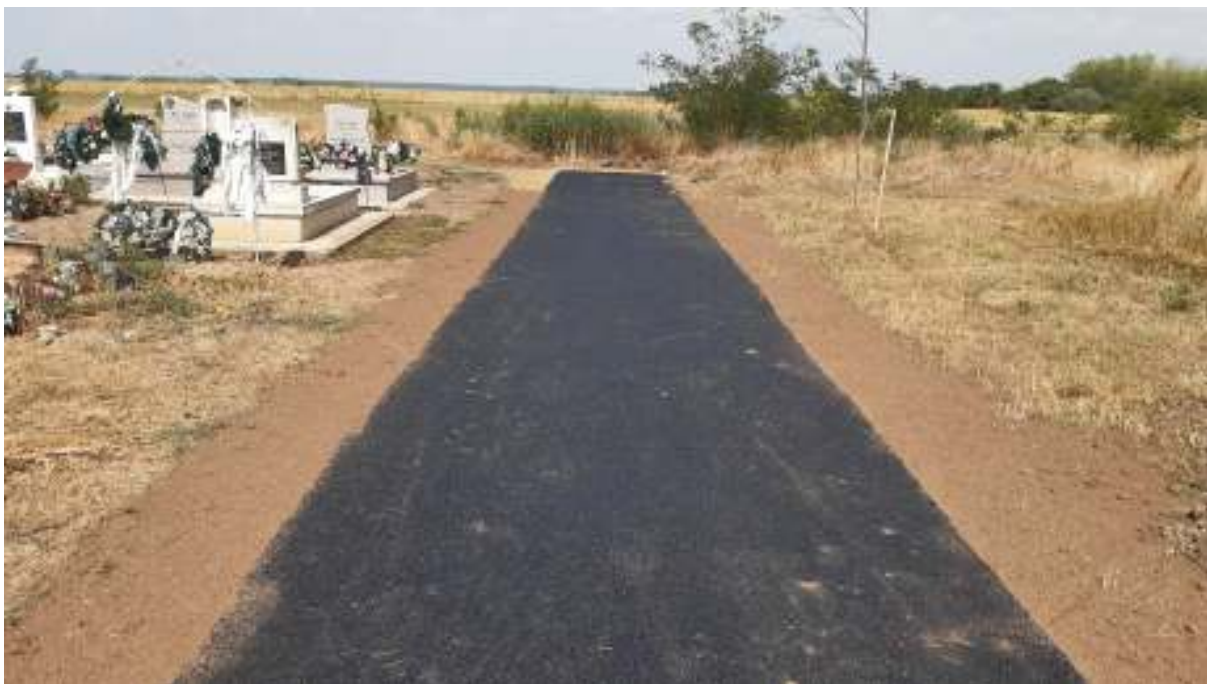
A 2. sz. belső út a 3. sz. út felől.
