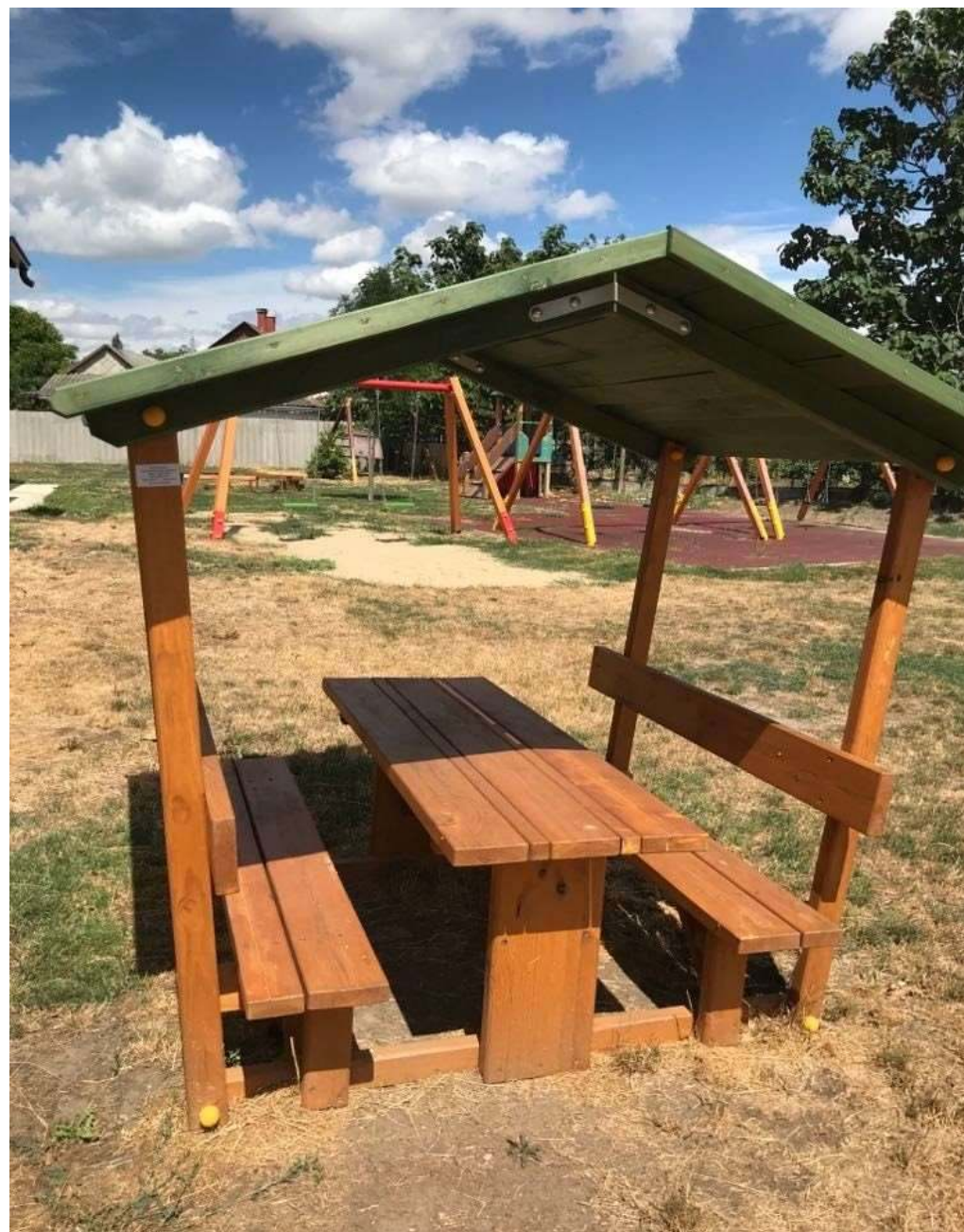
Tetős-kertiasztal-padokkal 1. sz. - Rákóczi u. 11.
