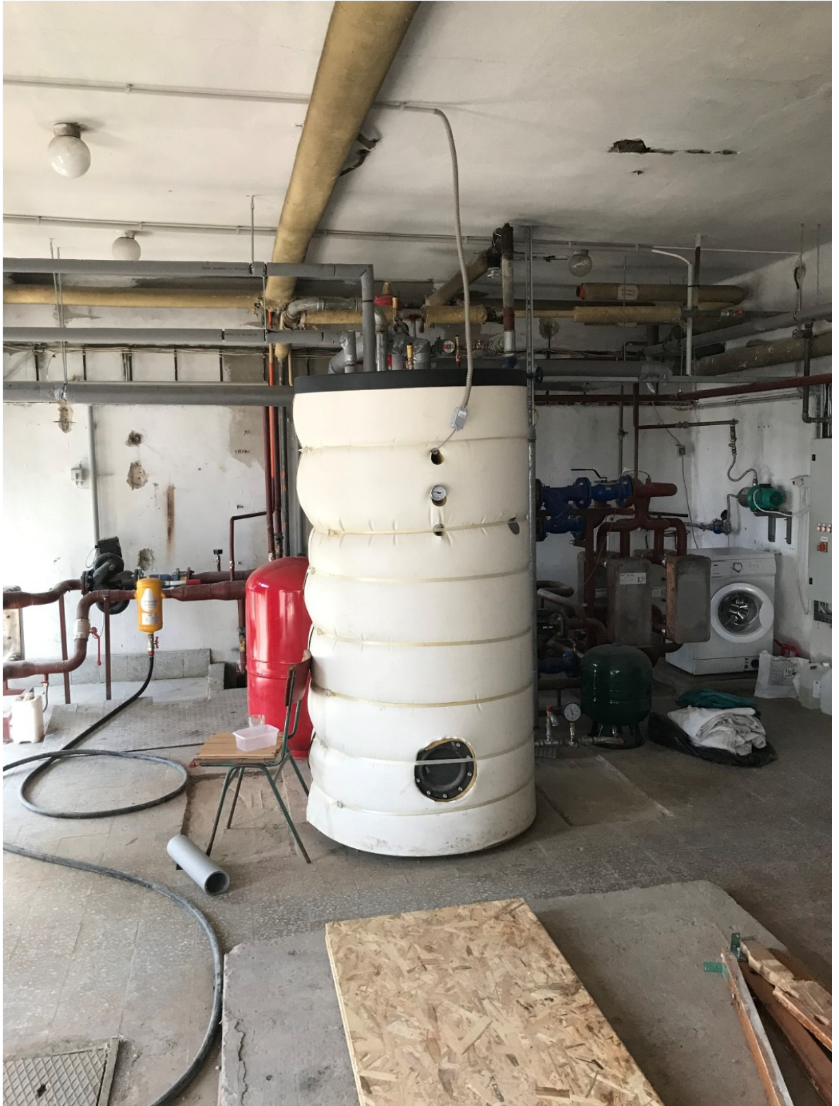
7. Puffertartály és a háttérben a geotermális fűtőblokk szerelvényei, amely egy előző TOP-os támogatással valósult meg
