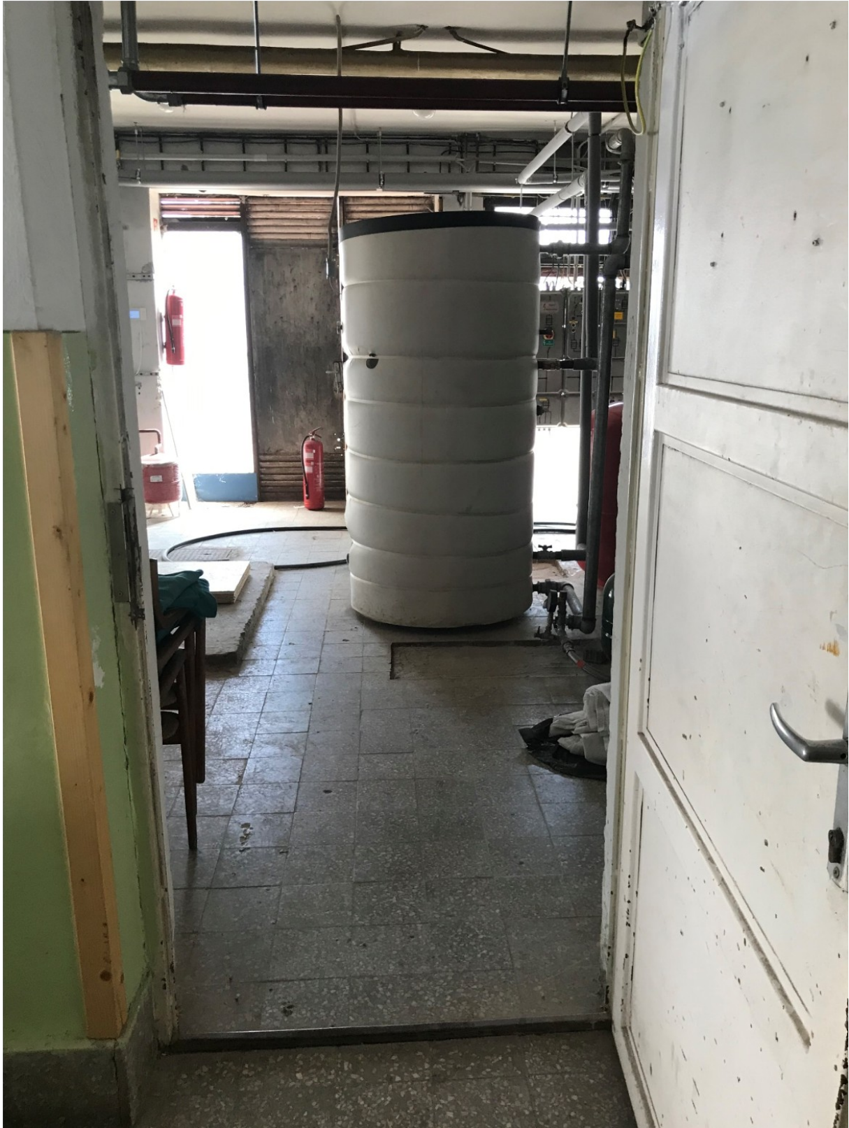
4. Puffertartály a használati melegvíz előállításához
