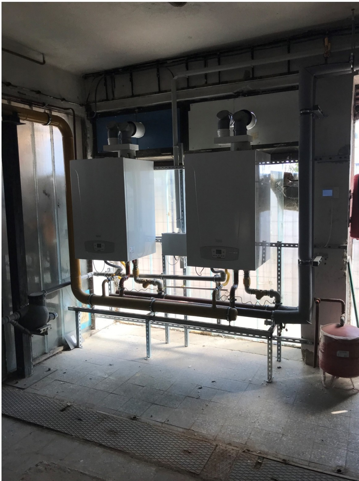
5. 2 db korszerű kondenzációs gázkazán és kiegyenlítő tartály, kondenzvíz mintavételi egység
