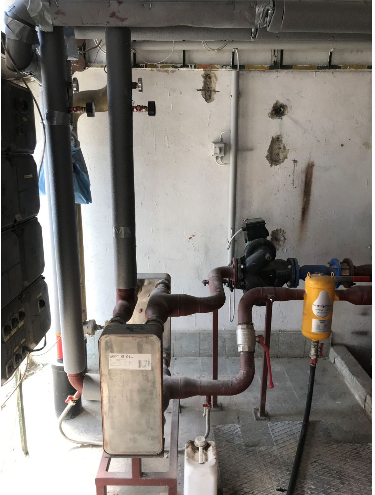
8. Lemezes hőcserélő és iszapleválasztó egység, nagyteljesítményű szivattyú a keringtetéshez
