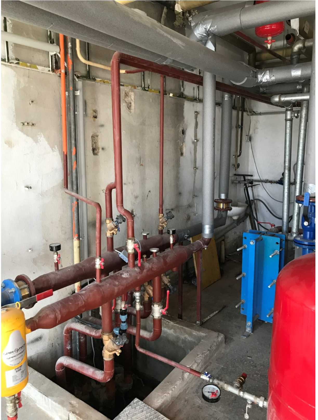
10. Új osztógyűjtő és szerelvényei, mellette a geotermális fűtőblokk és ezek összehangolására szükséges berendezések
