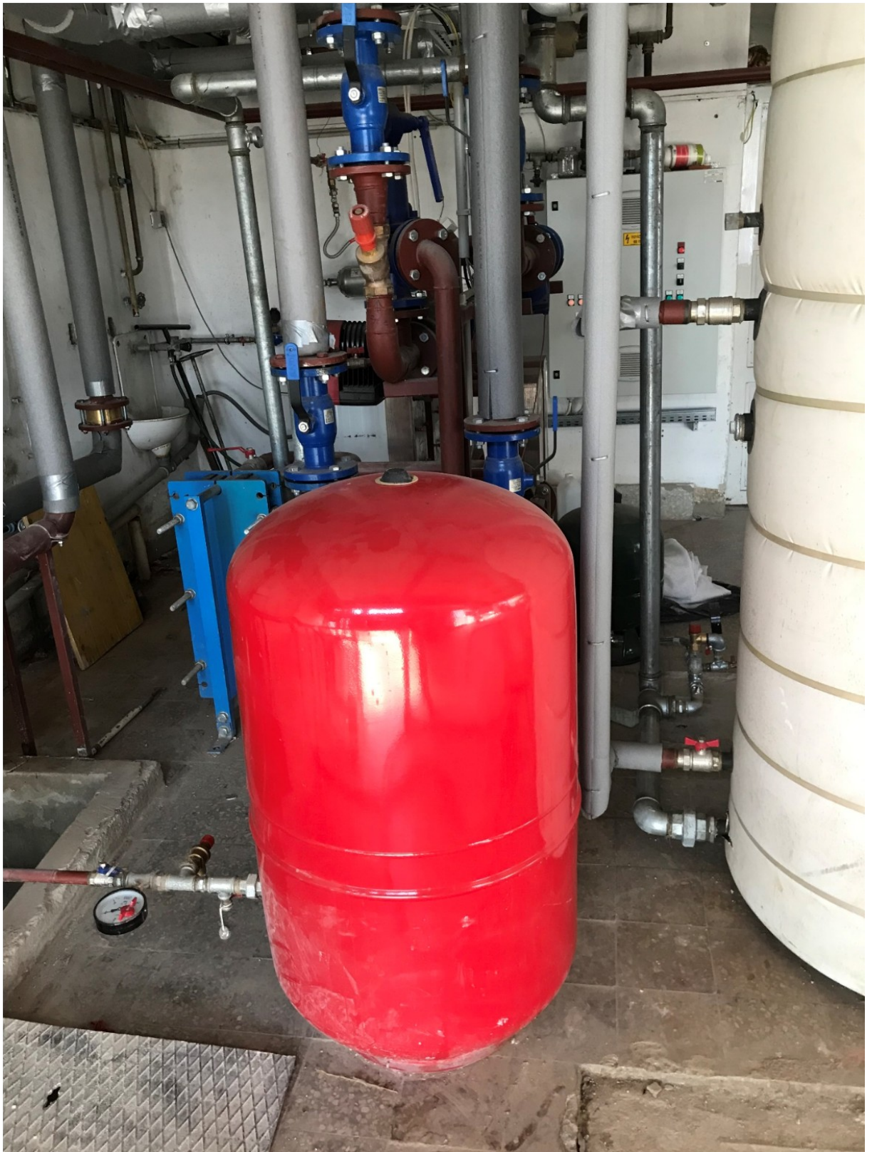
11. Teljes fűtési rendszer pótvizét biztosító kiegyenlítő tartály a puffertartály mellett
