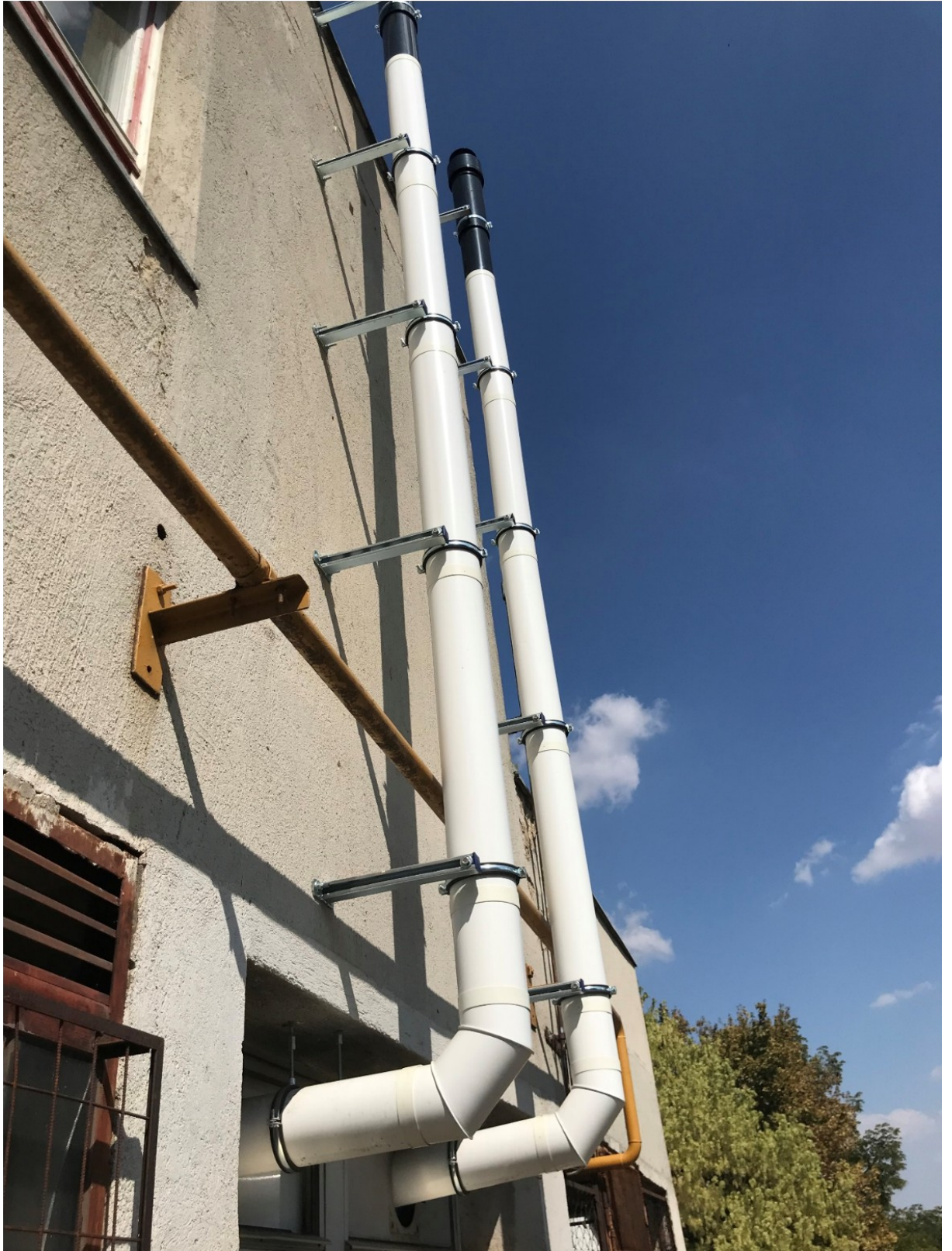
13. Kondenzációs gázkazánok kéményei
