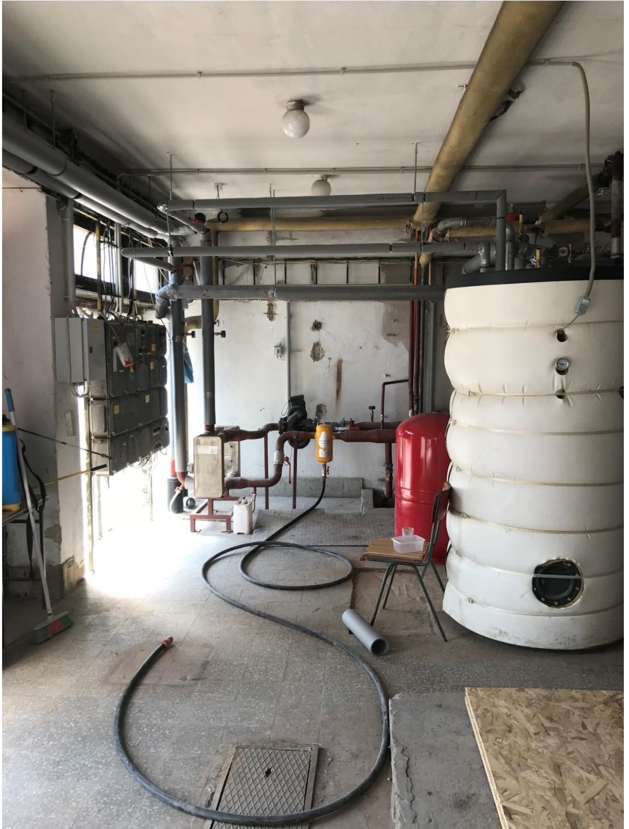
6. Puffertartály és vezérlés, kiegyenlítő tartály és iszapleválasztó berendezés, lemezes hőcserélő, nagy teljesítményű szivattyú
