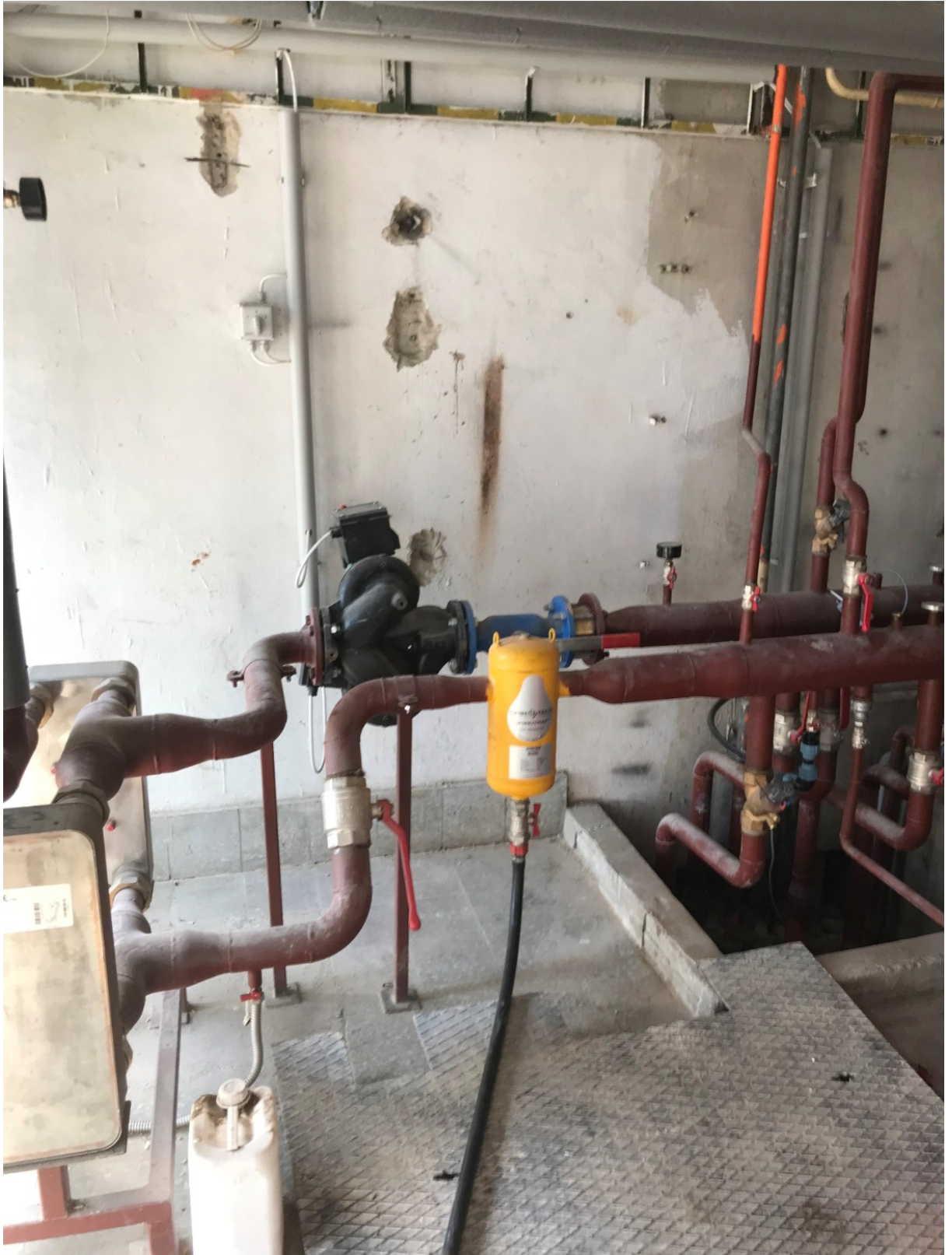
9. Új osztógyűjtő és szerelvényei
