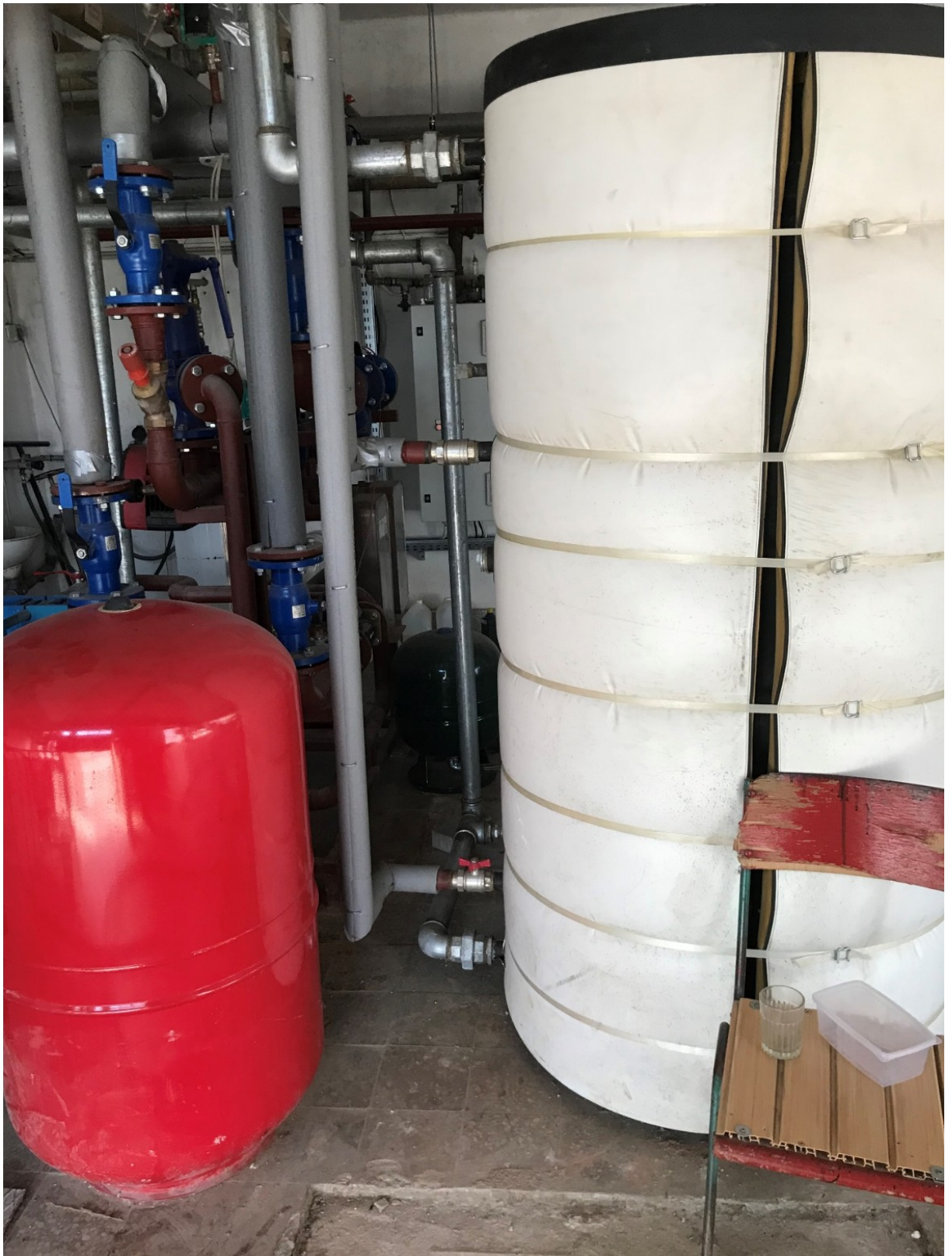
12. A kiegyenlítő tartály mögött látható a gázfűtést és geotermális fűtést összehangoló szerelvények
