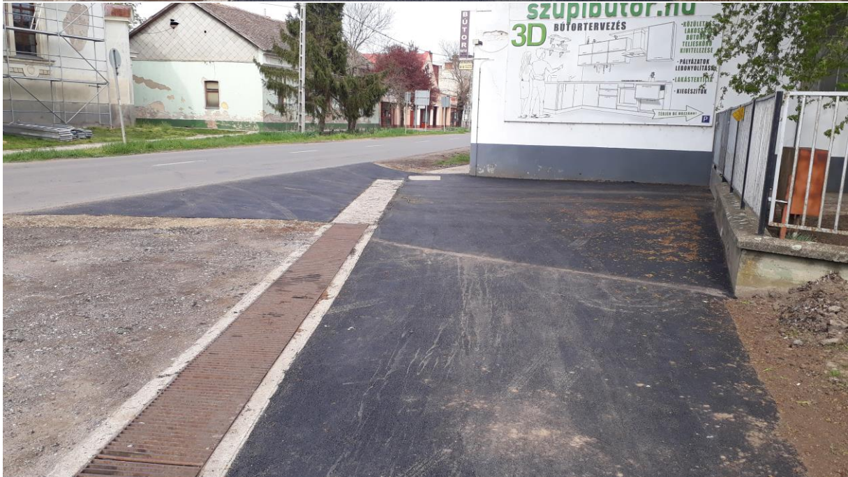
Földes, Karácsony Sándor tér aszfalt járda felújítás
