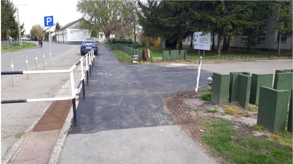
Földes, Karácsony Sándor tér aszfalt járda felújítás
