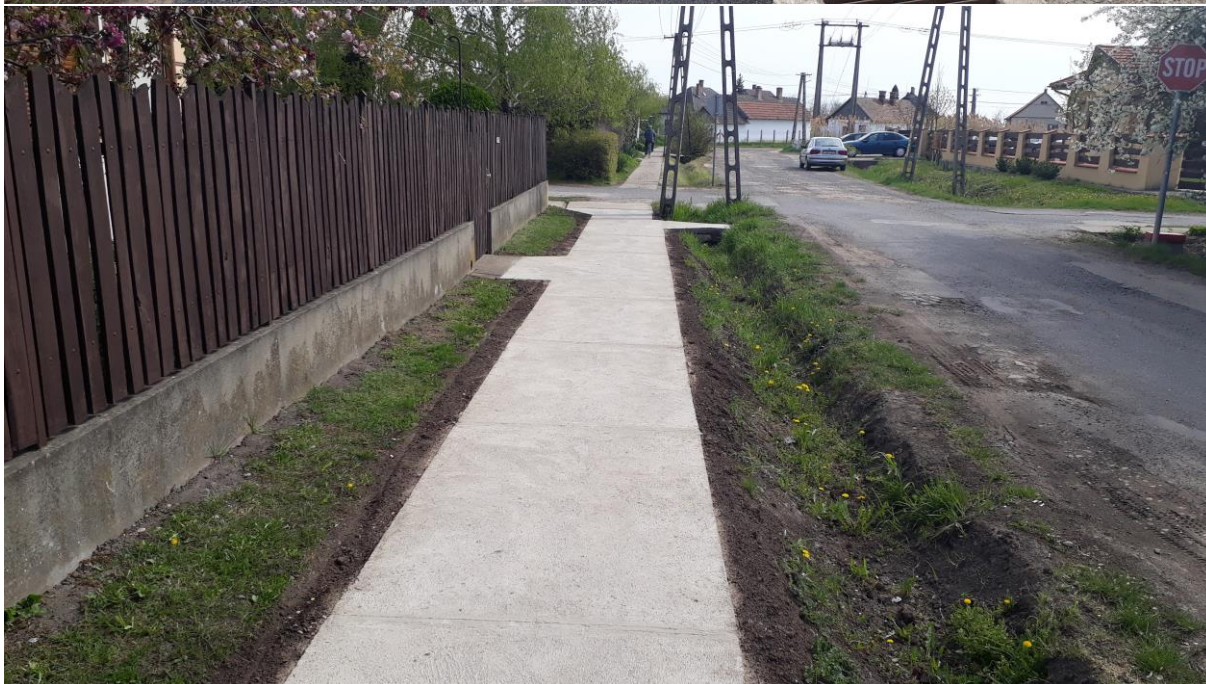
Földes, Karácsony Sándor tér aszfalt járda felújítás Földes, Mozi utca melletti járdaszakasz felújítása
