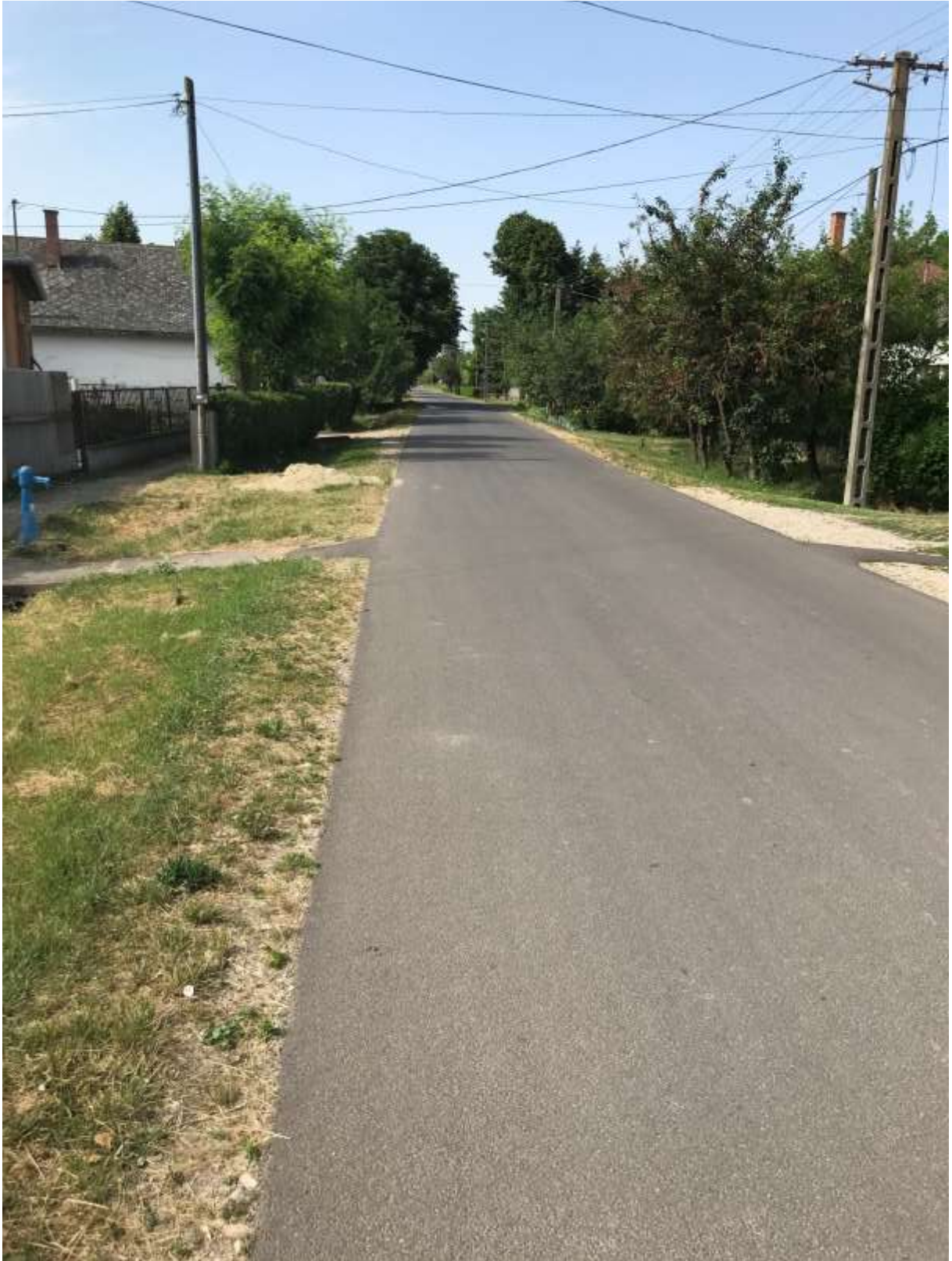
Dózsa György utca burkolatfelújítás – 4. fotó
