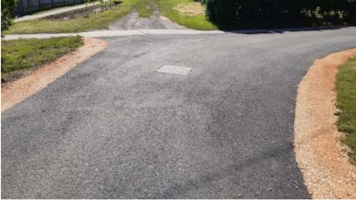
Piac u. – Dankó Pista u. találkozása (1017 hrsz.) a felújítással érintett utca vége
