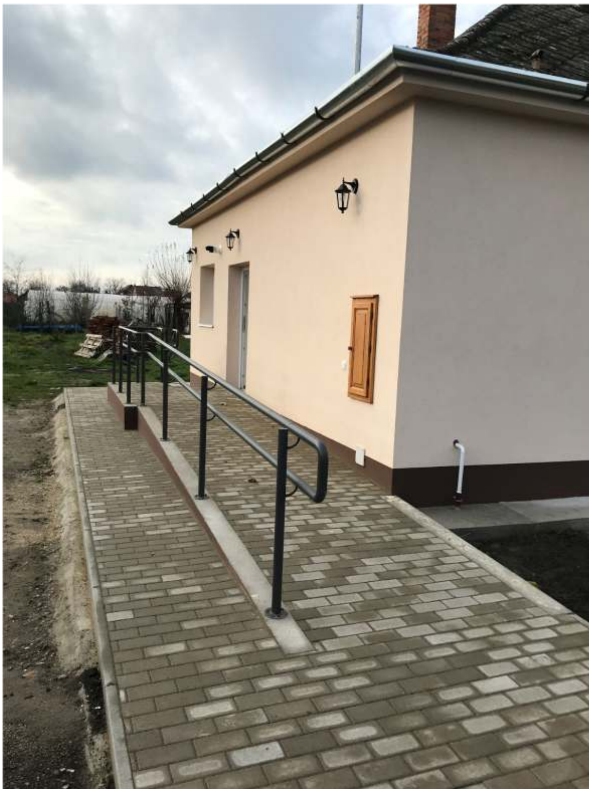
Ifjúsági Ház - Földes, Mozi u. 3.sz. – D-i homlokzat, akadálymentes rámpa és korlát
