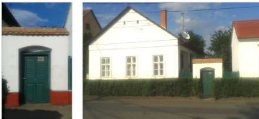
népi lakóház, gazdasági épület:
